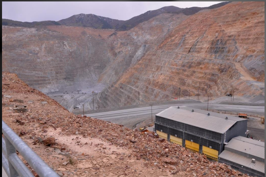
Jámový důl na měď Bingham v Utahu (4 km průměr, 800 m hloubka). Geršl, 2009
