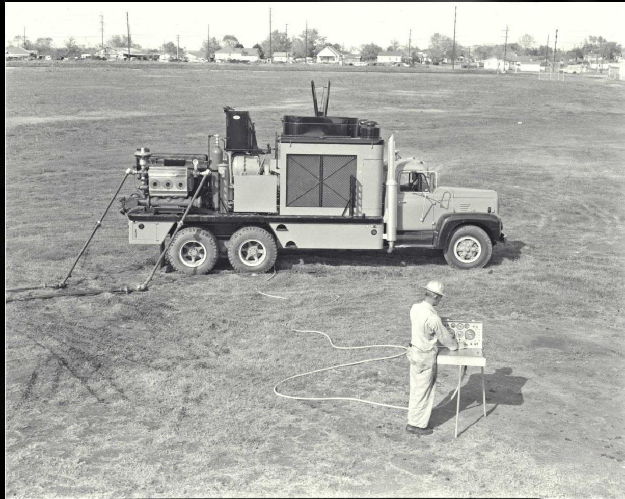
1950, Vtláčení motorem Allison letecký motor, 2. svět. válka
