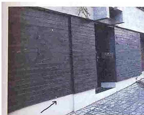
Obr. 12 - Příklad označení průchodu plynovodní přípojky do objektu
