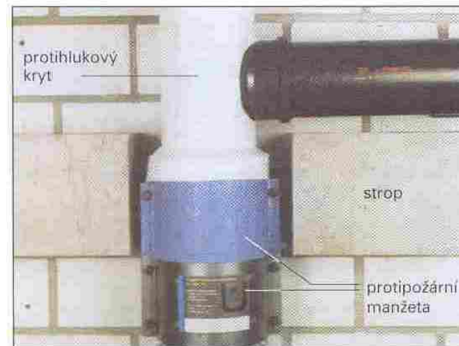
Obr. 1: Protipožární manžeta k zabudování do stropu
