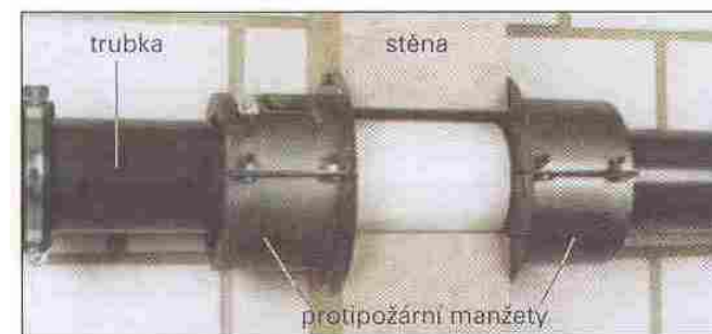
Obr. 2: Protipožární manžeta k zabudování do stěny
