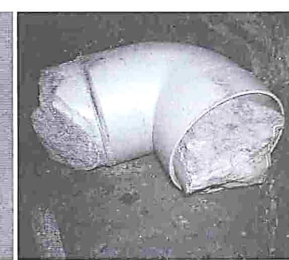
Obrázek 91: Potrubí PVC zainkrustované minerální vodou
