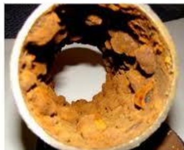
Obr. 1 Potrubí, které sloužilo k odvodu chladicí vody
