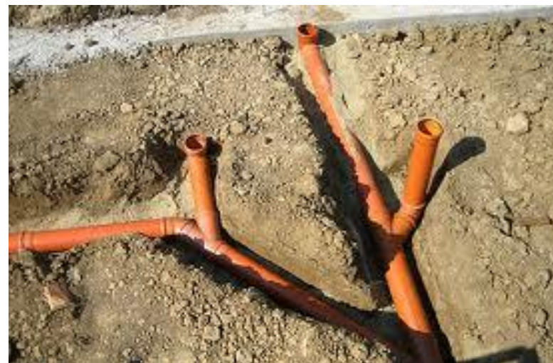
Obr. 1.32 Vzdálenost svodného potrubí od základu L – minimální vzdálenost výkopu pro potrubí od základu; 1 – základový pás nebo patka; 2 – výkop pro potrubí; 3 – svodné potrubí; 4 – podsyp potrubí
