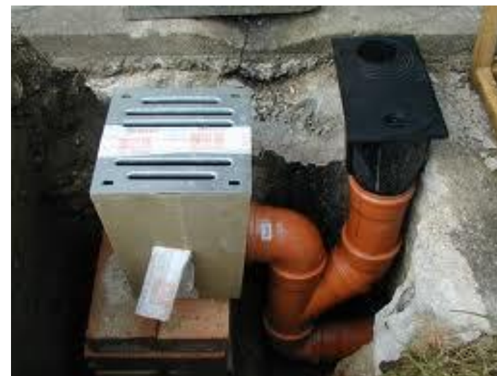
Obr. 1.41 Dvorní vpust s mechanickou zápachovou uzávěrkou 1 – litinová mřížka; 2 – koš na nečistoty; 3 – mechanická zápachová uzávěrka se zpětnou klapkou; 4 – těleso vpusti
