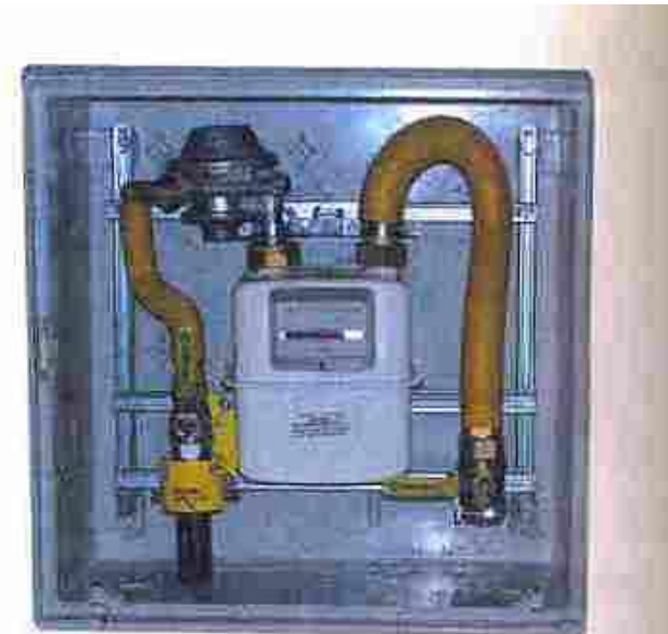
Obr. 4 - Příklad umístění hlavního uzávěru plynu regulátoru a plynoměru ve společné skříni
