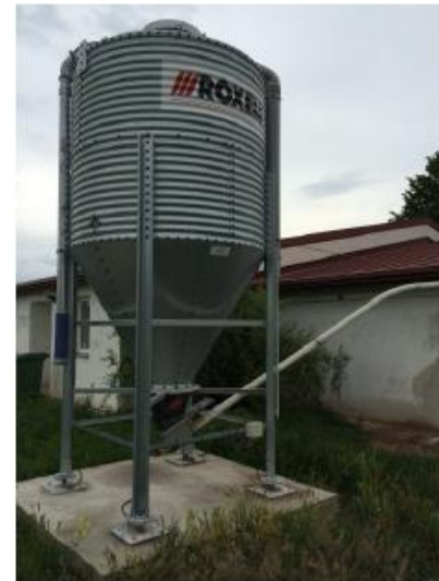
Obrázek č. 17 – Silo s kapacitou 4t
